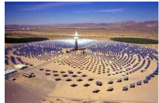
タワー形太陽熱発電システム
