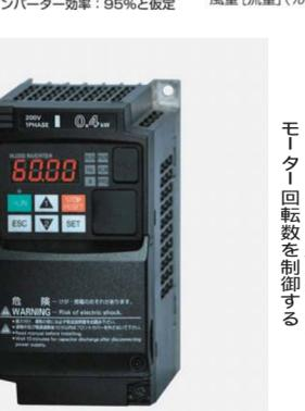
インバーターで周波数を変えてモーター回転数を制御する
