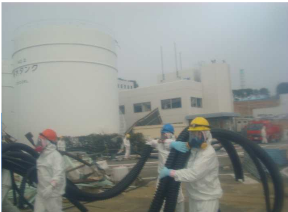
福島第一原子力発電所(1F)構内のケーブル敷設作業 (2011年3月18日)
